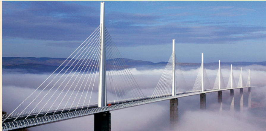
Viaduct von Millau über das Tarn-Tal in Südfrankreich, Tragwerksplanung von ARCADIS
